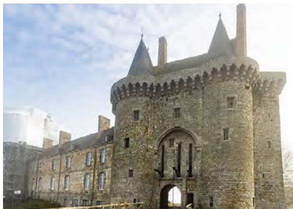
Château de Montmuran © Fondation du patrimoine - MyPhotoAgency-Sourcier
